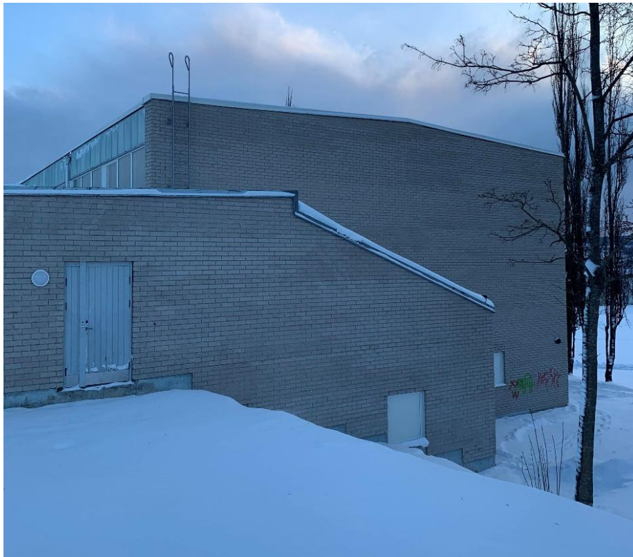
Figur 30. Franzénhallen har byggts i suterräng
