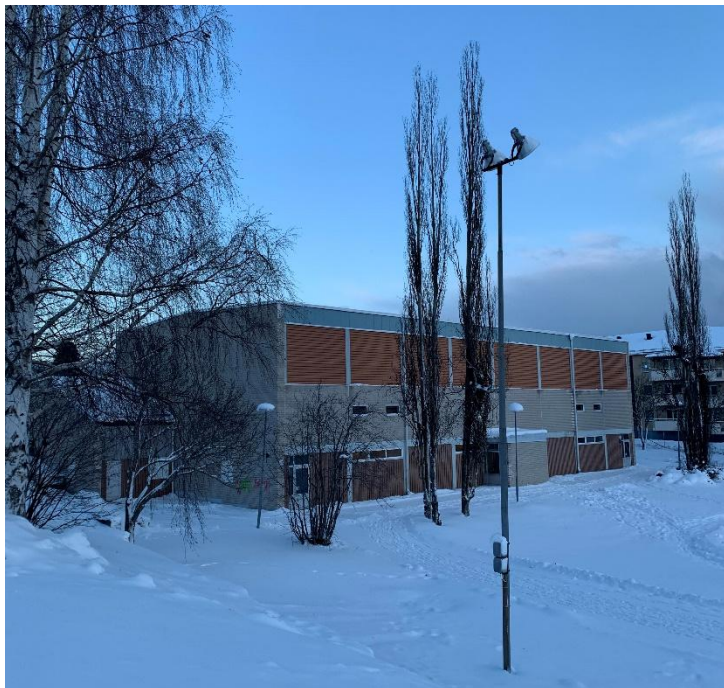
Figur 29. Franzénhallens södra fasad.
