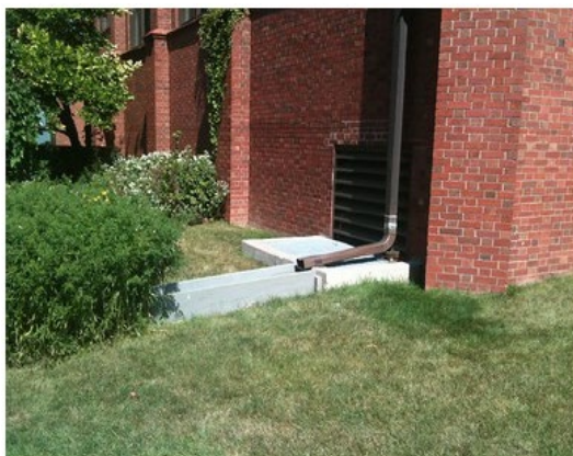
Figur 39. Stuprörsutkastare med tät vattenavledare. Structor Norr AB
