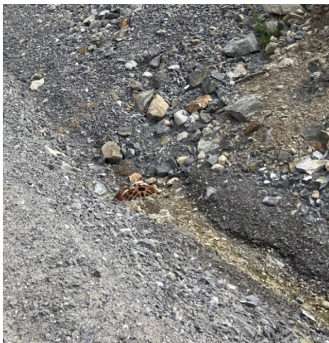
Figur 29. Dagvattenbrunnar i dike och på den nya vägen.
