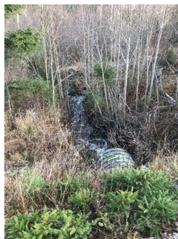
Figur 7. Vattenstråk som rinner under Saltviksvägen Foto: Hanna Krämmer
