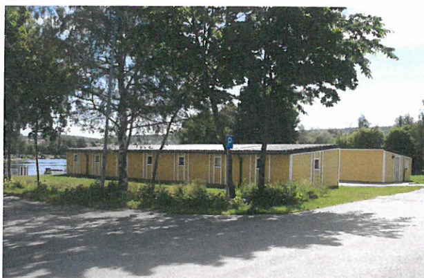
Vy åt sydöst, befintliga garagebyggnader
