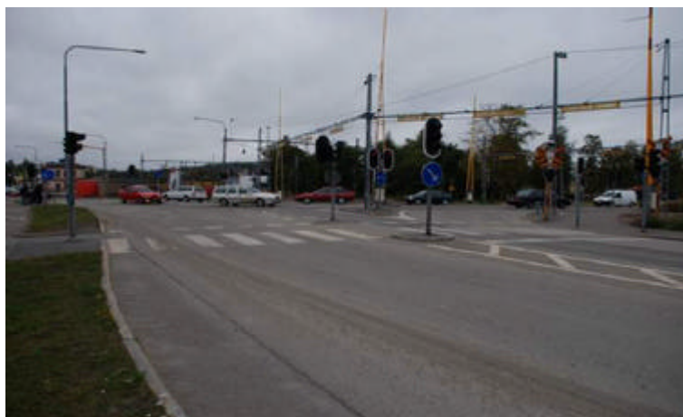
Figur 8. Befintligt utseende på plankorsningen mellan Bondsjöleden och järnvägen
